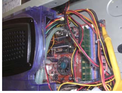
Resimde işlemcinin soğutucusu üzerine yerleştirilmiş su borularını görebilirsiniz.
