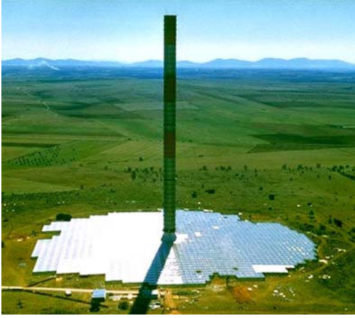
Schlaich, 1982 yılında Madrid'in yaklaşık 150 kilometre güneyindeki Manzanares kasabası yakınlarında 50 kilowatt'lık bir güneş kulesi prototipi inşa etti.
